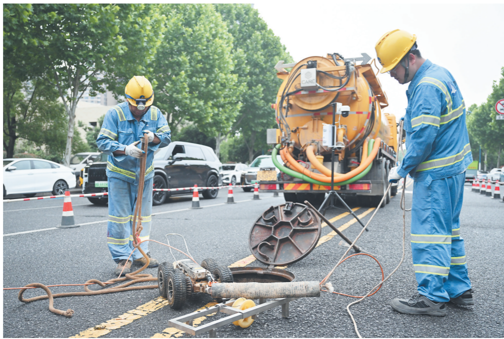
施工人员正准备将管道检测机器人放入井内作业。长沙晚报全媒体记者 余劭劼 摄
